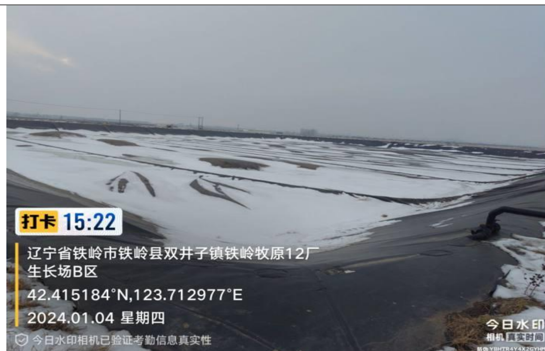
黑膜储存池（B区）
