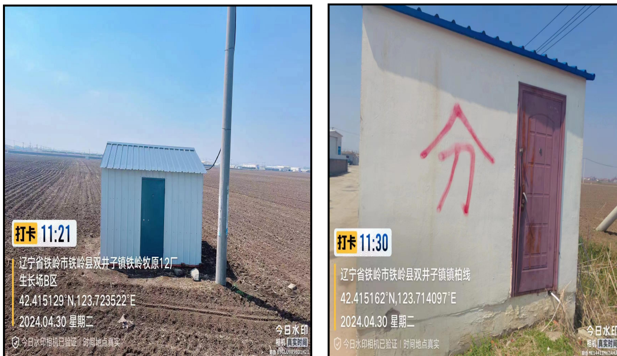
图 5-4 地下水跟踪监测井照片
