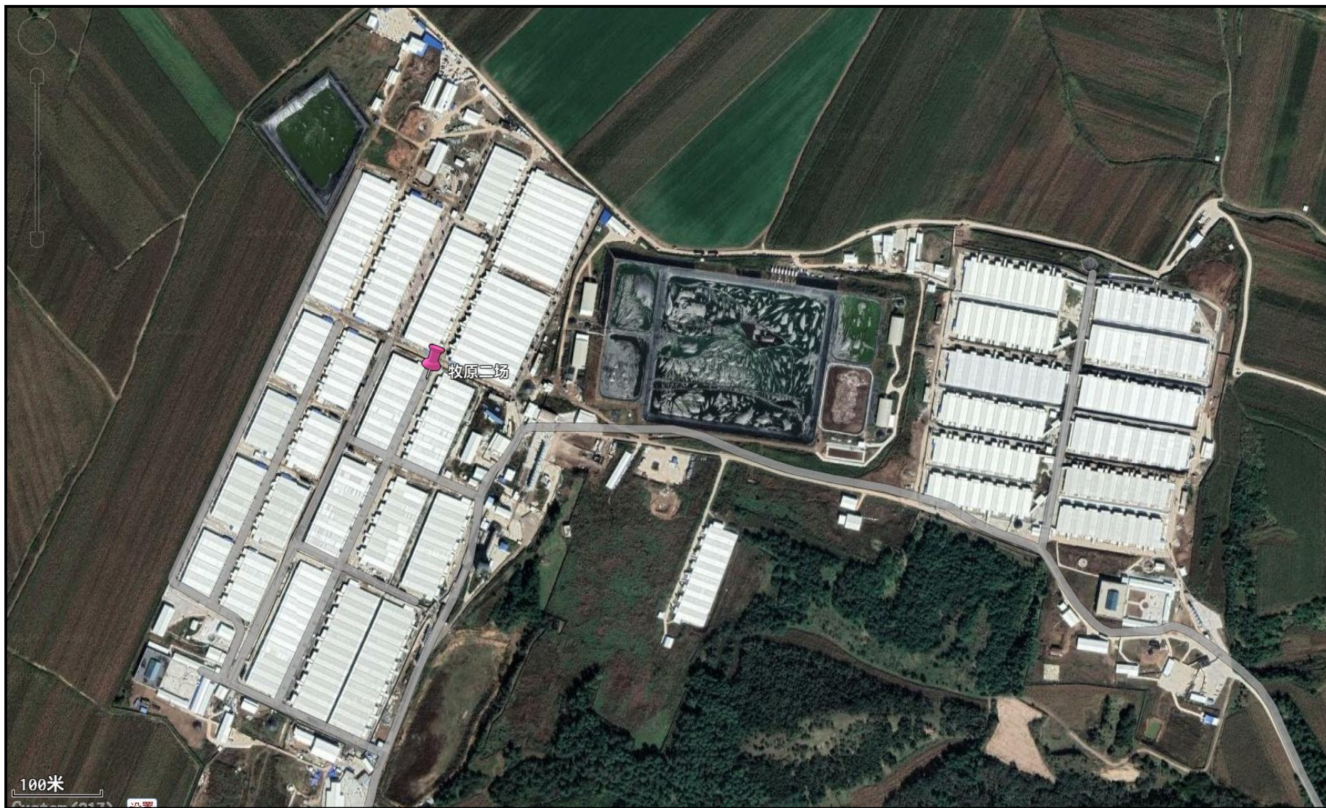
图 3-2 辽宁铁岭牧原农牧有限公司铁岭二场航拍图
