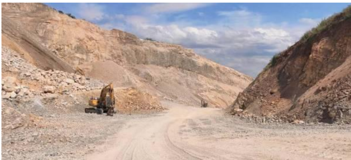
图 3-1 二采区部分边坡
